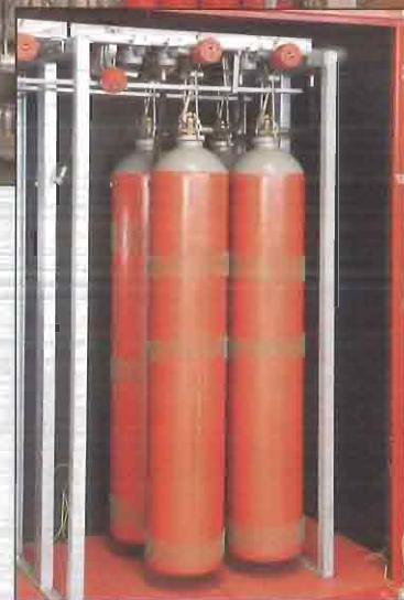
Nelle foto in alto i Gruppi a CO 2 bassa pressione nello stabilimento durante la costruzione. A fianco il particolare di uno dei gruppi CO 2 alta pressione che mostra il sistema di comando e pesatura.
