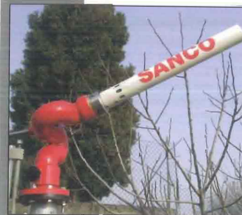
Monitori BM90 dotato di canna schiuma e Monitori BM80 con bocchello acqua/schiuma SBA1600.
