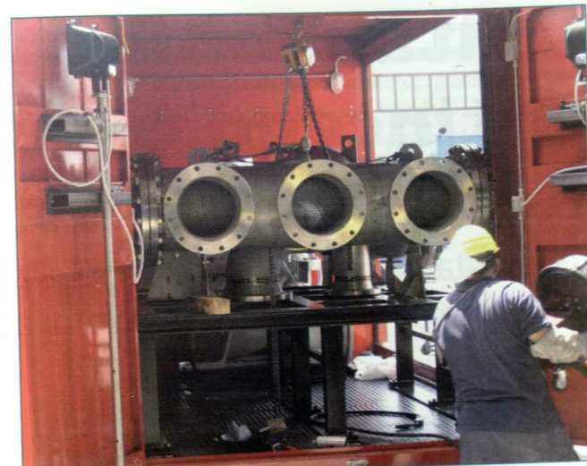
Fig. 2 Particolare del "manifold di aspirazione" durante la sua installazione
